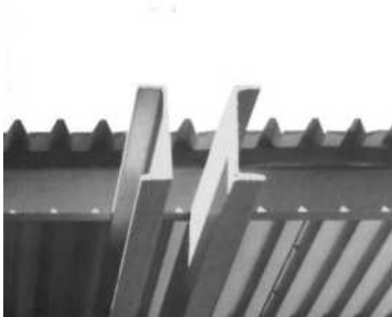
Vigas sobresaliendo de la cubierta de la Casa de Puerta de Hierro. Madrid, 1961.
