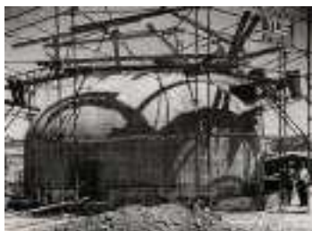
Bóvedas gunitadas de hormigón armado.
